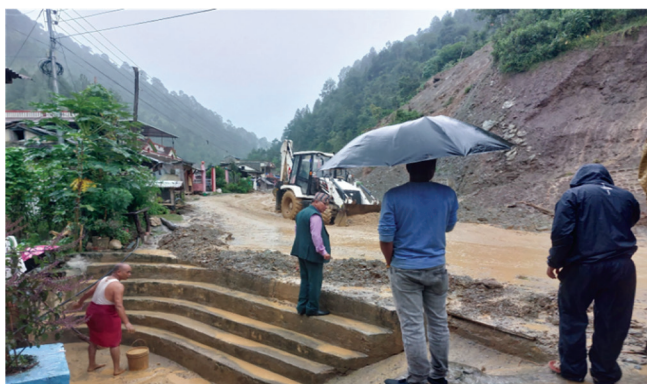
झिमरुक गाउँपालिकामा रहेको निर्माणाधीन सडक, मदनभण्डारी राजमार्ग
